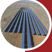
SARAR&ILGAZLAR GÜNEŞ ENERJİ SANTRALİ
